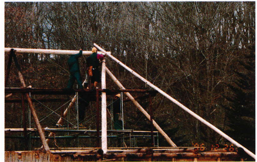
写真1 東面のケトゥンニ（三脚）の取り替え：白く見える斜めの木4本のうち、一番右はシッケウリカニ。その他の3本がケトゥンニ。西面にも同じ三脚構造が設けられ、東西のケトゥンニの頂点に棟木（キタイオマニ）が渡される。
