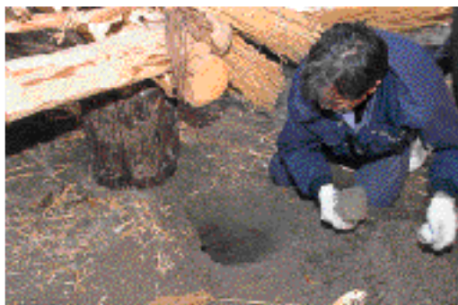
写真3 小屋組の外周に柱穴を掘る
