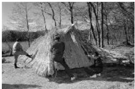
写真2 地上での屋根葺き
